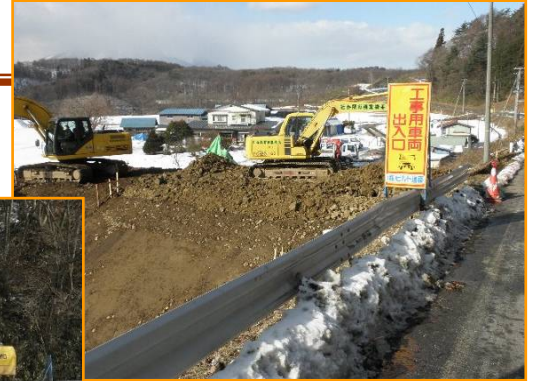
施工状況写真
