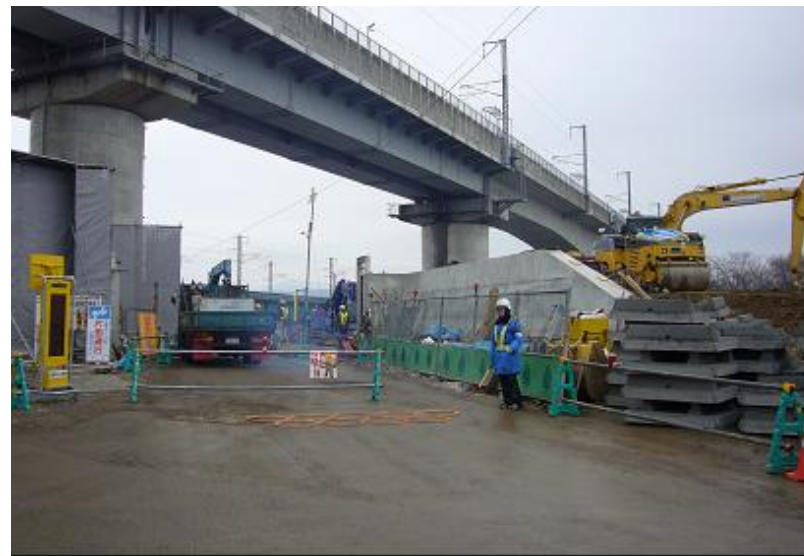
写真 1-3 雫石陸閘（仮称）施工状況
