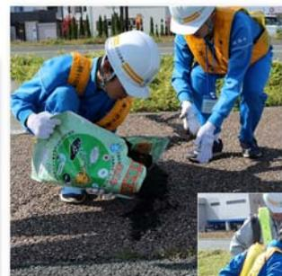
▲パッチング。穴ぼこに常温アスファルト合材を投入し、踏み固めます。
