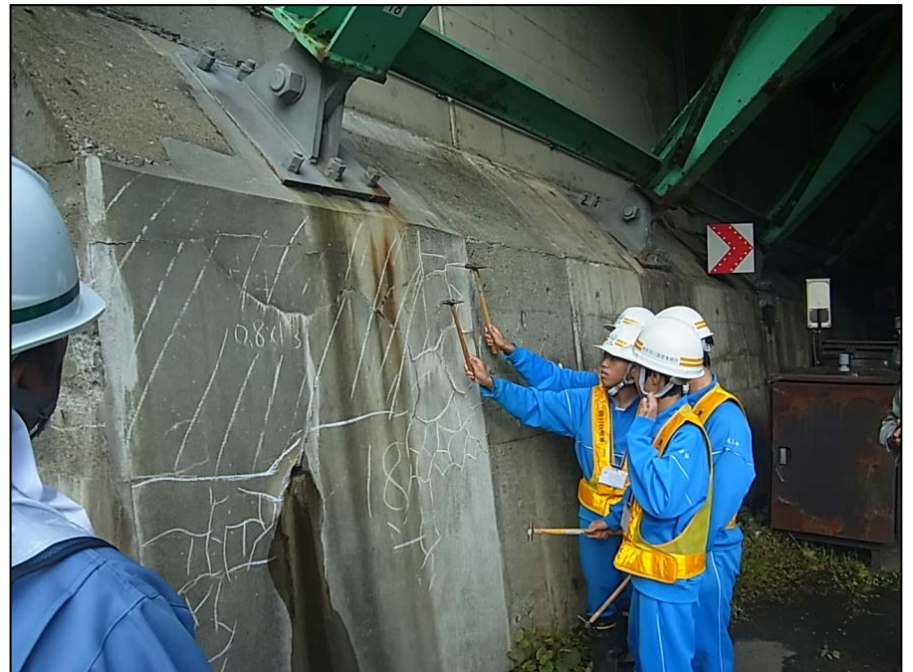
▲橋の土台をハンマーで叩いて点検する様子
