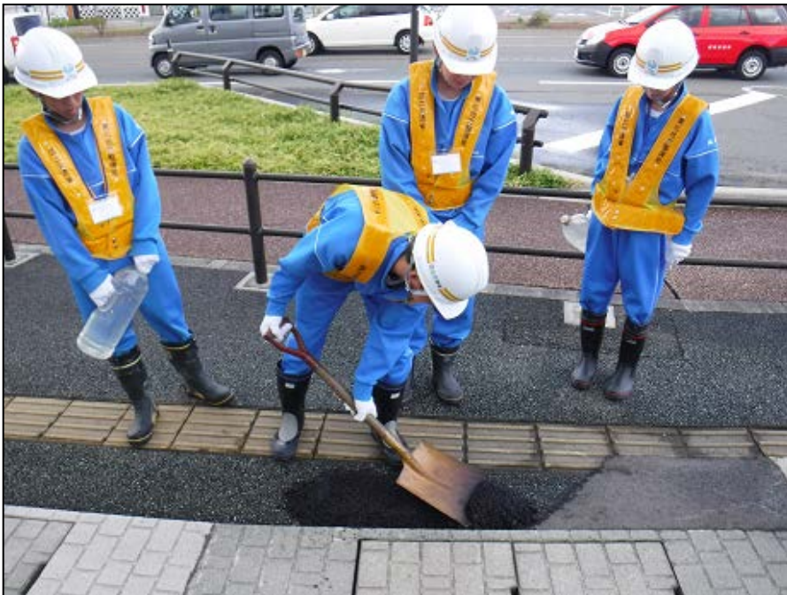
▲穴を早急に埋めるパッチング作業の様子
