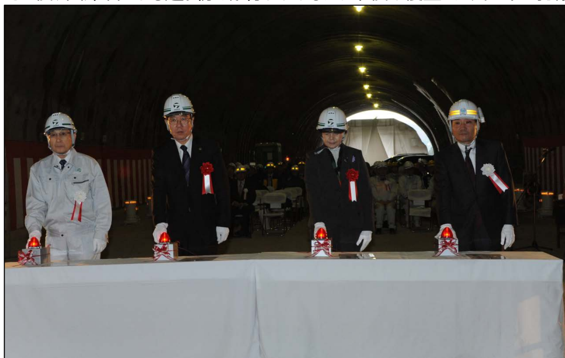
▲貫通掘削ボタンを押す関係者の皆さん
