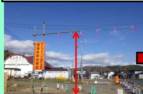
簡易ゲートに高さの標示が無い
