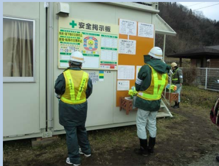
現場点検①
