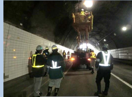
現場点検②
