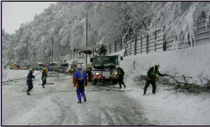
倒木撤去作業の状況
