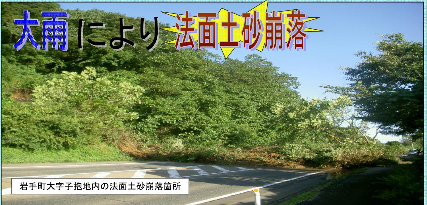
岩手町大字子抱地内の法面土砂崩落箇所
