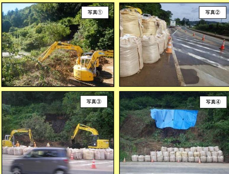
【写真①】翌17日早朝から復旧作業開始。【写真②】2車線分の土砂を撤去し、ゼブラ帯を活用して応急的に対面通行開始。【写真③】片側交互通行により、土砂撤去再開。【写真④】車道部の土砂を撤去し、通常通り通行が可能となりました。今後も道路外側の土砂撤去のため、片側交互通行が行われます。
