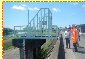
樋門・樋管 合同点検
