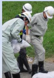
ぎゅっと締め固めたら、鉄の杭でさらに固定
