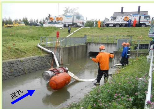
【溜まった水を吸い込むために排水ポンプをセットします】
