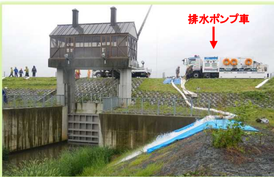
【吸い上げた水を吐き出しています】
