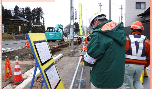
工事現場の点検
