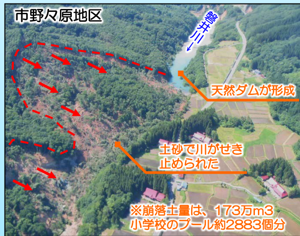
被災直後の状況
