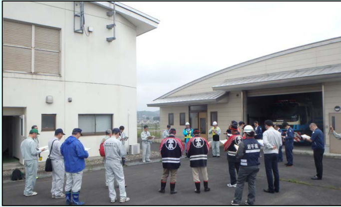
[北上川 平泉排水機場]
