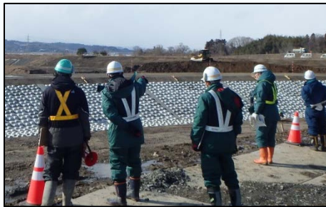
施工箇所点検
