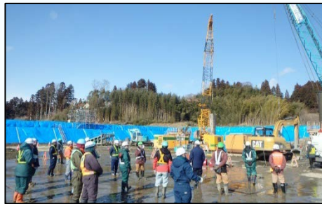
施工箇所点検
