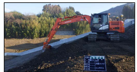
3D制御バックホウ作業
