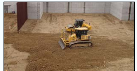
3D制御ブルドーザー作業
