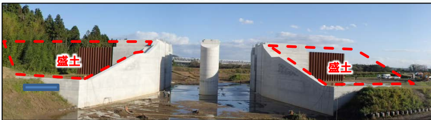
築堤盛土 着工前
