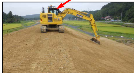
法面整形作業
