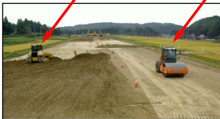
盛土材 敷均し、転圧作業
