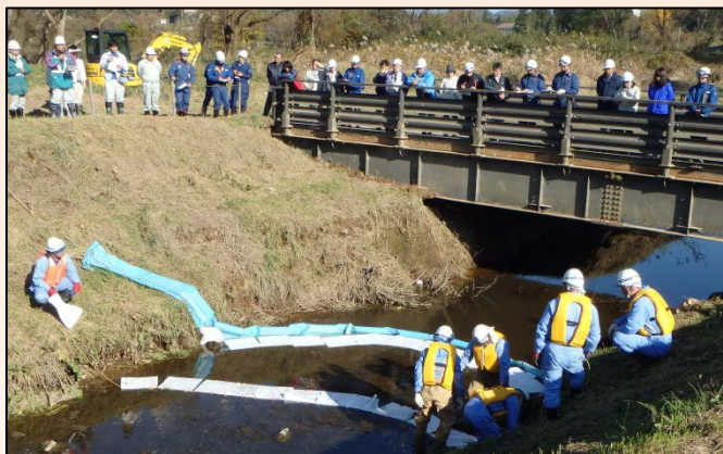
オイルフェンス設置訓練 (オイルフェンスを張り、吸着マット(万国旗型等)で油を回収)
