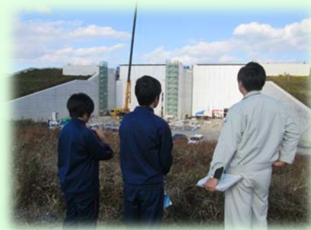
一関遊水地大林水門 ゲート設備新設工事現場
