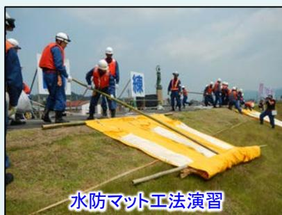
川表の漏水面に水防マツトを張る(縦土のう袋付きで加工された物)
