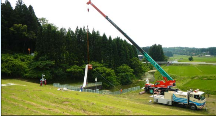
クレーンによる排水ポンプ(能力:60m 3 /min)設置の様子
