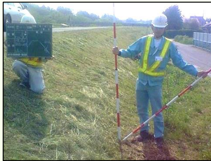
【出水時把握訓練】 堤防 漏水状況
