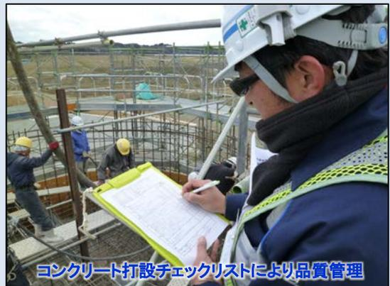
平成28年3月23日に、午前7:45～午後16:00にかけ中央堰柱9回目となるコンクリート約307m<sup>3</sup>が打設されました。コンクリート打設には、作業員一人一人が決められた作業手順に従って作業を行っていました。
