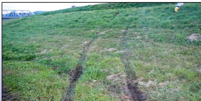
昨年度河川巡視で発見したタイヤ痕。車両等により堤防の法面を損傷させる行為は河川管理上支障をおよぼすおそれのある行為として禁止されており、「河川法」に違反する行為になります。
