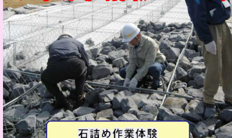
石詰め作業体験
