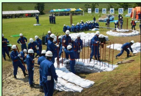
水防隊員による「月の輪工法」訓練
