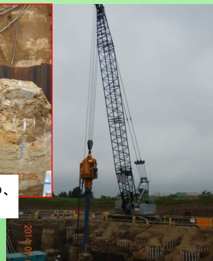
90kwパイロハンマによる打ち込み
