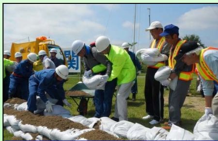
自主防災組織や地元高校生、専門学校生が参加しての「積み土のう工法」訓練
