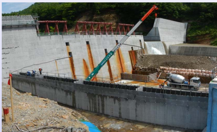
工事が進む「槻木平砂防堰堤」6月9日撮影
