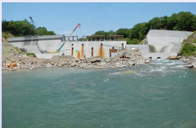
下流側から「槻木平砂防堰堤」を望む6月9日撮影
