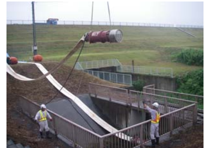
クレーン車でホースと接続した水中ポンプを下ろします。(実際には浮輪(写真内のオレンジ色のもの)も接続します。)
