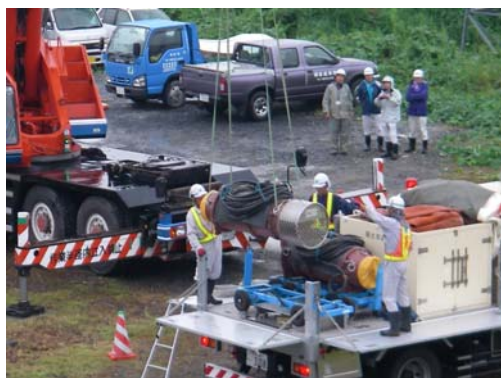
←60m 3 /分のポンプのため、設置するにはクレーン車が必要になります。
