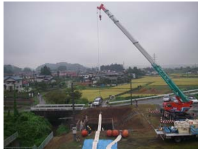
クレーン車でホースと接続した水中ポンプを下ろします。(実際には浮輪(写真内のオレンジ色のもの)も接続します。)
