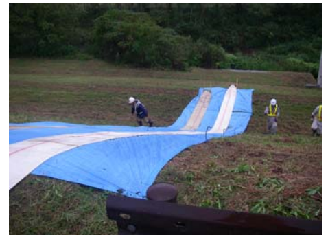
↑堤外側(河川側)設置完了!!
