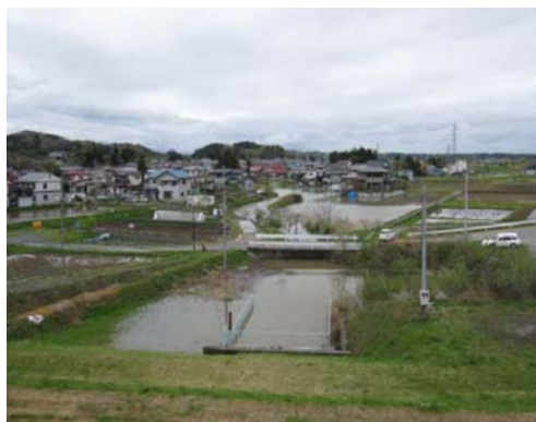
←H24.5 出水時の内水による浸水状況 (鈴沢川)
