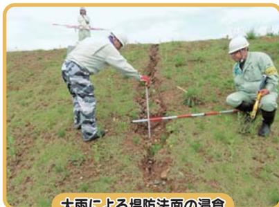
大雨による堤防法面の浸食
