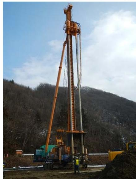
↑全高が約30mあるこの機械で、最大で地下約18mまで地盤改良を行っています。
