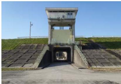
↑操作員の方々が操作している排水樋門(写真左)と陸こう(写真右)。平常時は排水路や道路として利用しますが、洪水により増水した場合にはゲートを閉めることで、堤防と同じ働きをします。
