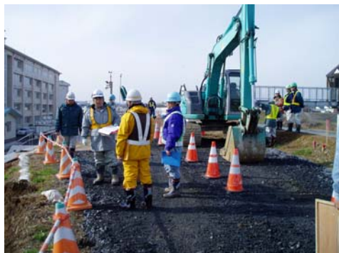
↑ 磐井川堤防の工事現場を点検
