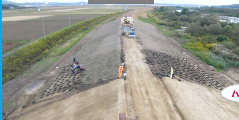
現在、盛土作業は概ね完了し、最後の仕上げとして張芝作業を行っています。 **11月末に、堤防が完成します！**
