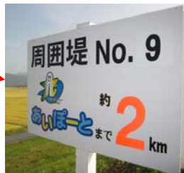
災害時や河川巡視時に点検箇所を把握するために設置した「堤防管理用標識」周囲堤の管理ナンバーと併せて両面にそれぞれ「あいぼーと」までの距離と「あいぼーと」からの距離を表示しました!!
