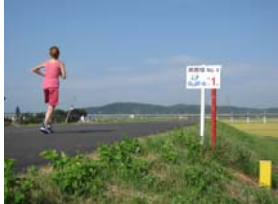
災害時や河川巡視時に点検箇所を把握するために設置した「堤防管理用標識」周囲堤の管理ナンバーと併せて両面にそれぞれ「あいぼーと」までの距離と「あいぼーと」からの距離を表示しました!!
