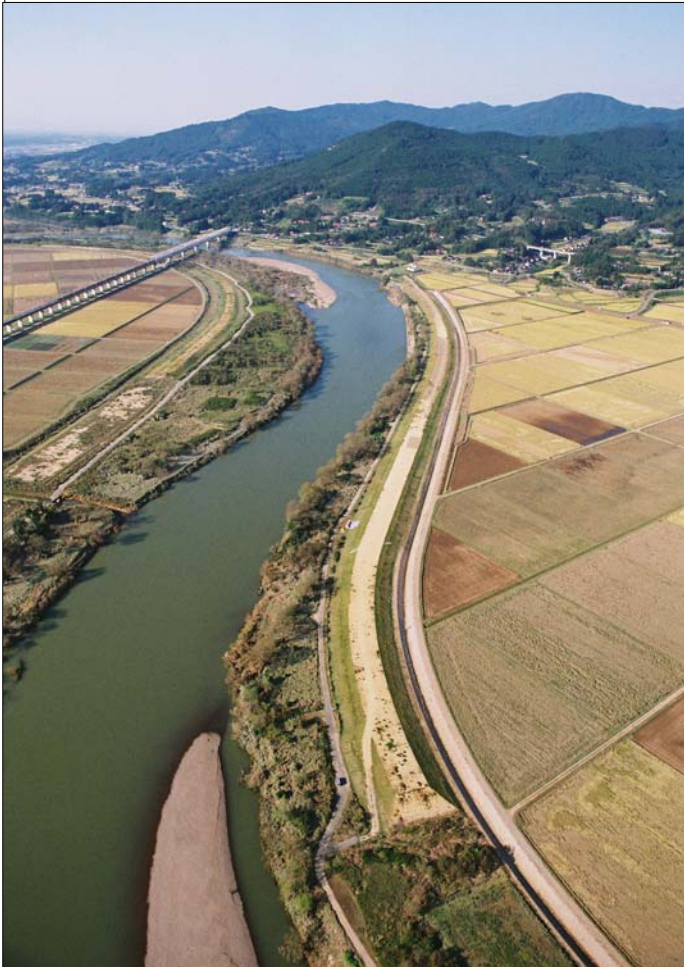
一関遊水地第3小堤舞川地区築堤工事:着工前
