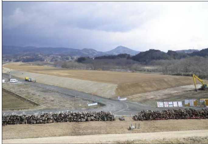
一関遊水地第1管理堤中里地区上流築堤工事:完 成
