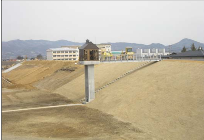
一関遊水地花王町排水樋門改築工事:完 成
