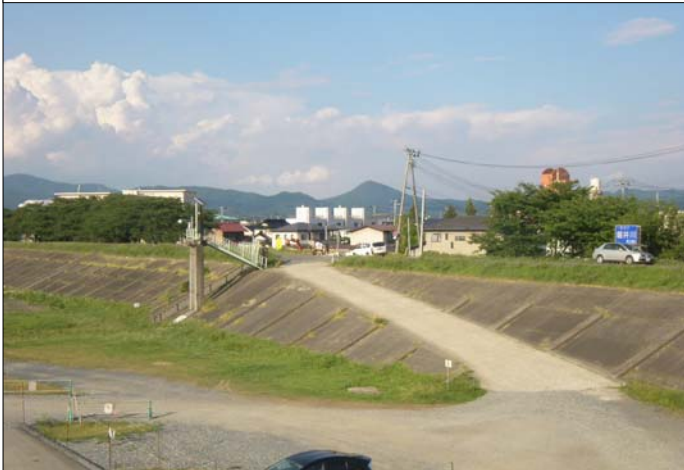
一関遊水地花王町排水樋門改築工事:着工前
