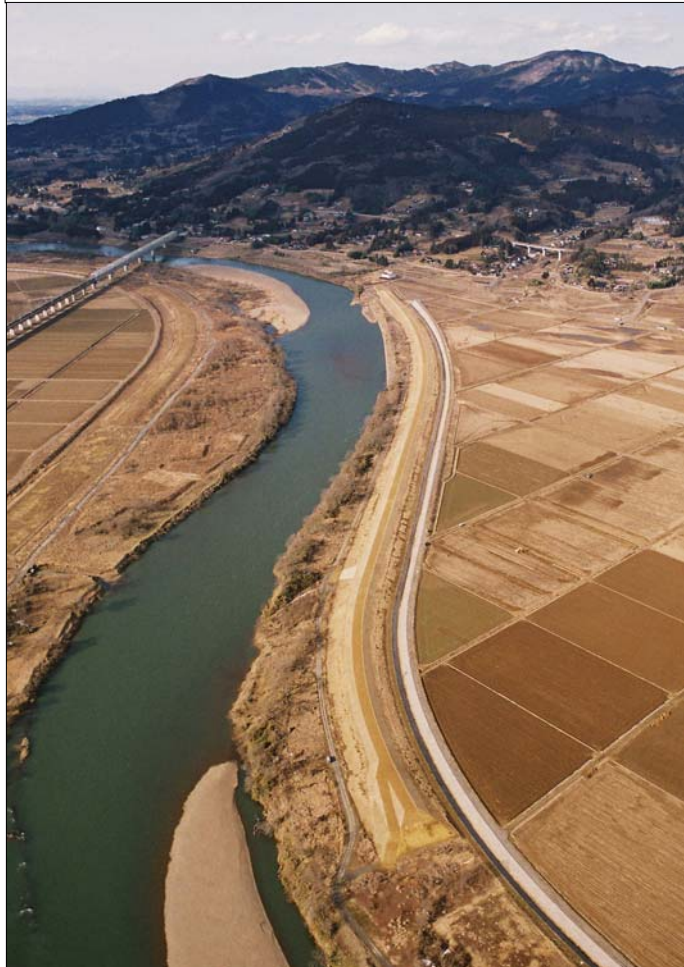
一関遊水地第3小堤舞川地区築堤工事:完 成
