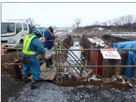
現場点検の様子 第1管理堤中里地区下流築堤工事
