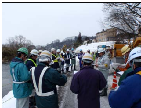
現場点検の様子 磐井川本町護岸工事
