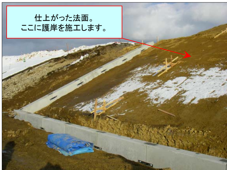
護岸ブロック基礎設置完了
