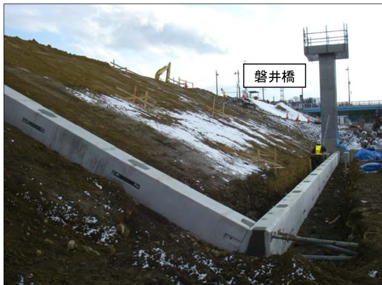
法面整形した後、護岸のブロック基礎を設置します。
