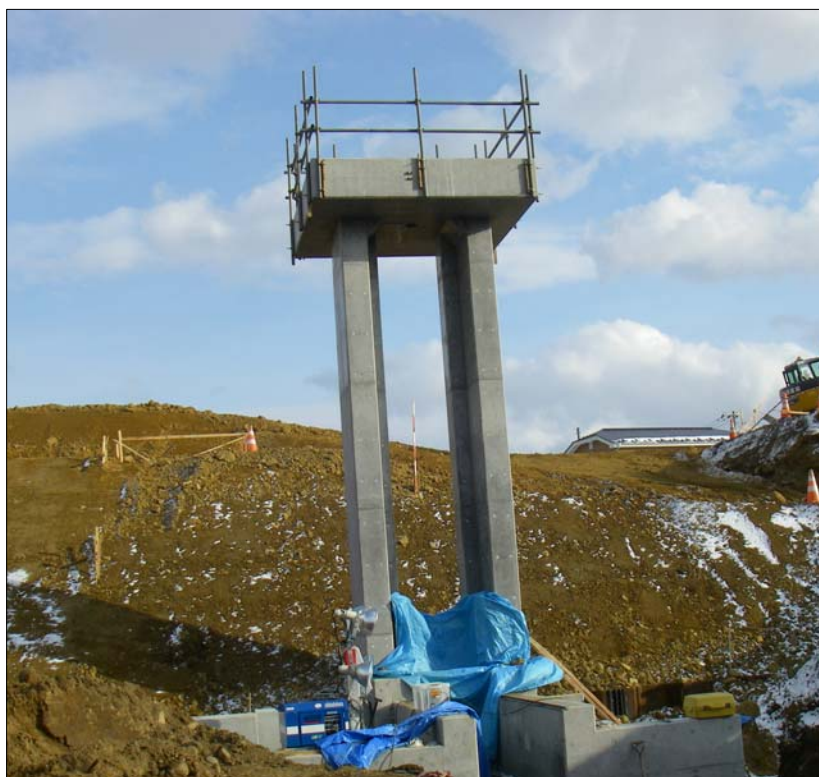
扉体と上屋を設置するコンクリート構造物
