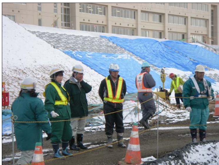
現場点検の様子 「一関遊水地花王町排水樋門改築工事 工事現場」
