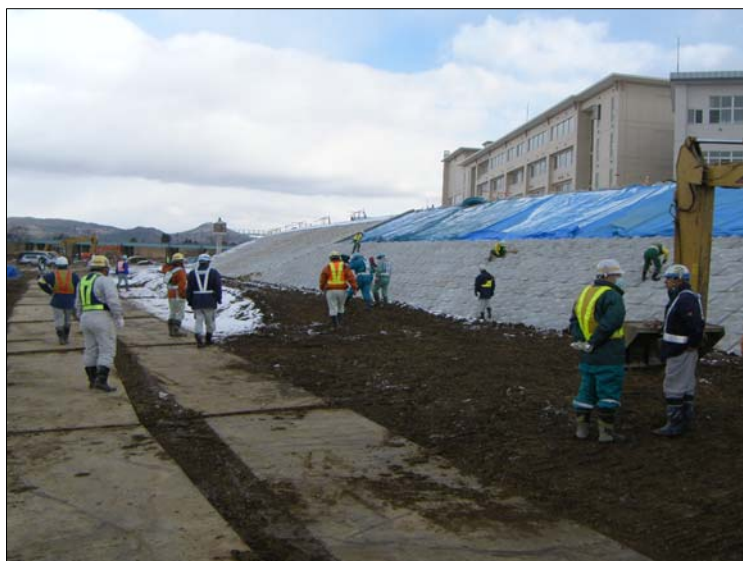
現場点検の様子 「一関遊水地磐井川磐井町地区築堤工事 工事現場」
