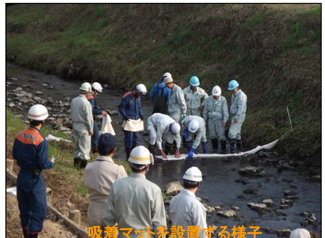
ロープを張り吸着マットを設置する訓練
