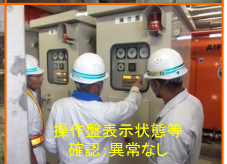
排水ポンプ稼働状況確認 異音・漏水なし:異常なし
