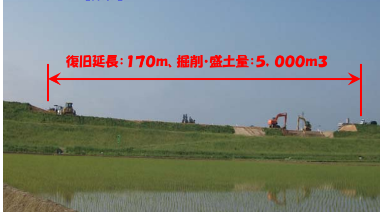
【周囲堤防の復旧状況】 地震により崩落及び段差の生じた箇所を掘削し、新しい良質な土で盛土します。
