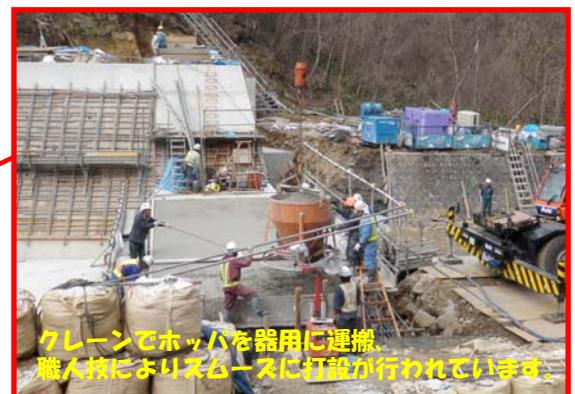
クレーンでホッパーを器用に運搬。職人技によりスムーズに打設が行われています。
