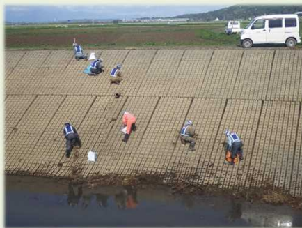
法面清掃・除根作業
