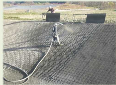
モルタル吹付
