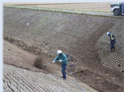
IP-スcoop による掘削
