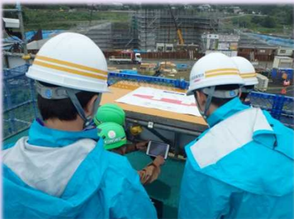
施工管理について学びました。
