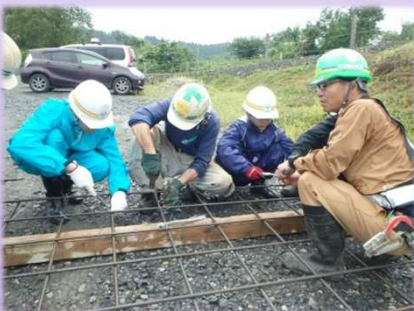
鉄筋組立体験をしました。
