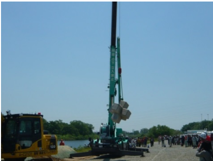
国土交通省によるブロック投入
