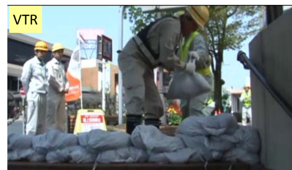
盛岡駅東口地下道の避難誘導と浸水防止の土のう積み
