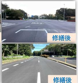
国道4号と国道282号、県道16号と3つの 号、県道16号と3つの 道差点」を含む区別を 差点」を含む区別 が生じた舗装にひびどれや轍(わだち)なり が生じた舗装する工え を行い、併せて見まして くくなった区画線アルしました。
