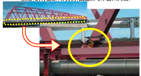
損傷(鋼材破断)の実例(国道23号木曾川大橋)
