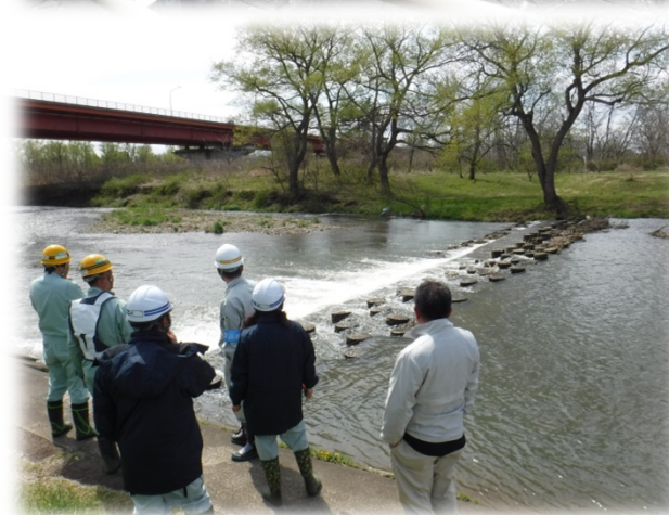
関係機関との合同点検状況
