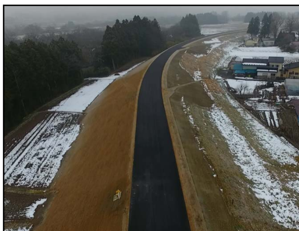
工事完成状況(上流側)
