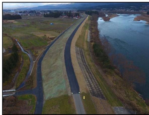
工事完成状況(下流側)
