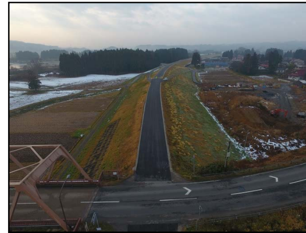
工事完成状況(赤生津橋付近)
