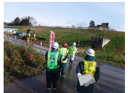
工事現場の点検
