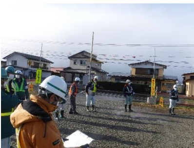
現場代理人から工事概要等の説明を受けます
